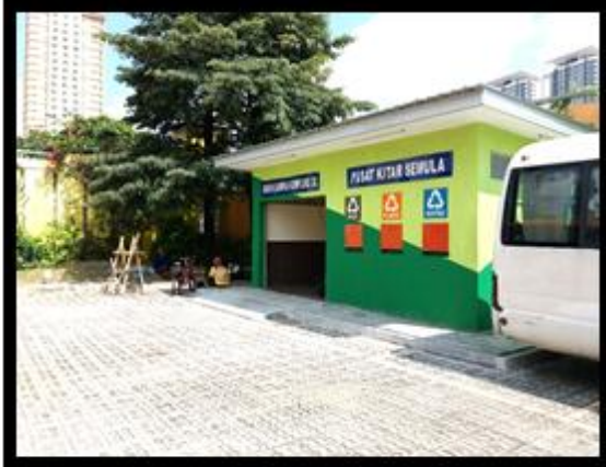
RUMAH SAMPAH DI PINTU 1
